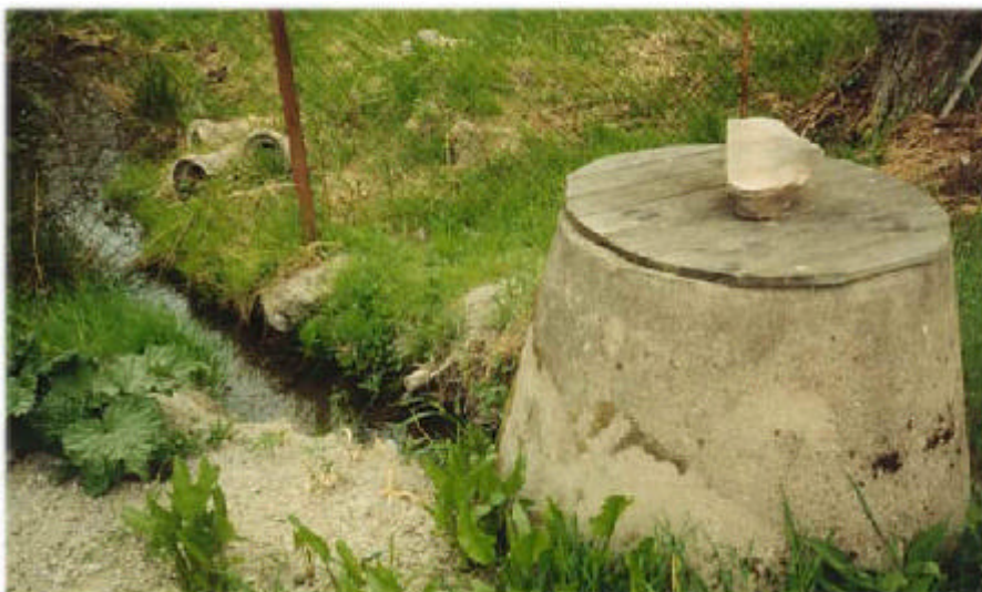
Figur 14. Bristfällig avloppsanläggning, foto: Anders Fröberg.
